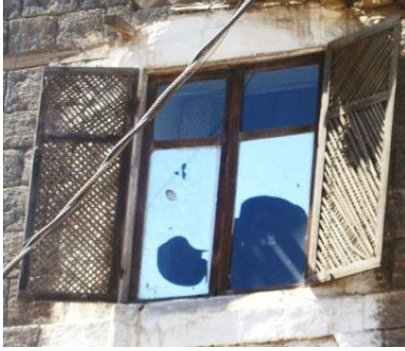
لوحة (10) نافذة زجاجية مغطاة بشباك ذات بمصراعين
