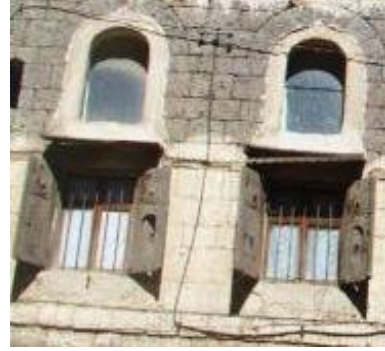
لوحة (9) نوافذ الزجاج المغطاة بالمصاريع الخشبية
